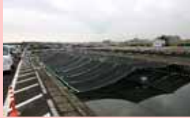
アユふ化水路全景 (紫外線防止ネットを水路上に張った状況)
