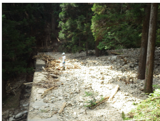
谷止工で土砂流出を防いでいる状況
