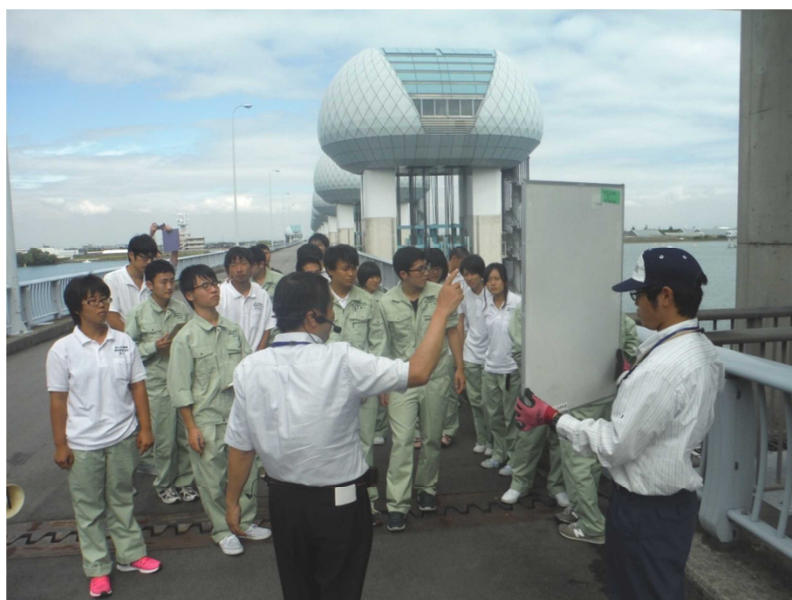
(H28. 09. 27 長良川河口堰県民調査団の視察状況)
