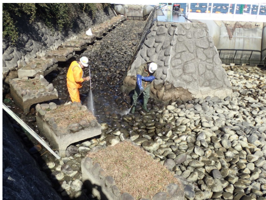
右岸せせらぎ魚道清掃状況
