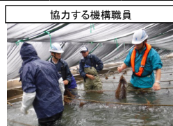
シュロの装着作業(水路に設置した横断ロープに装着)
