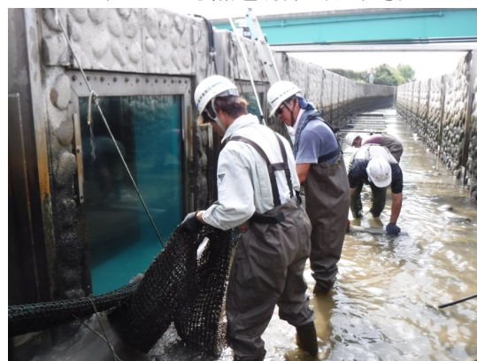
左岸呼び水式魚道清掃状況
