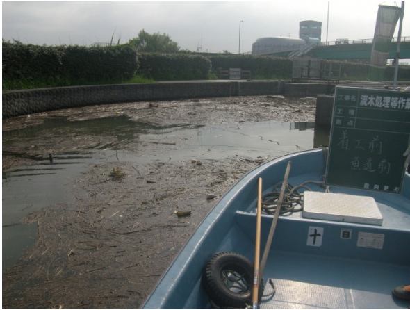
(堰上流(左岸魚道)に滞留した漂着物)
