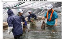
シユロの装着作業(水路に設置した横断ロープに装着)
