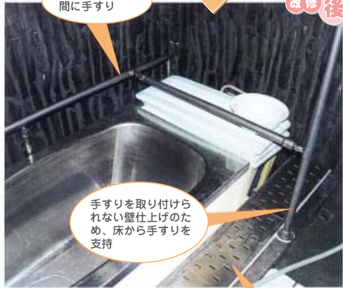
浴槽と洗い場との隙間に排水目皿を兼ねたカバーを設置
