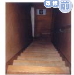
片側到手すりがある。
