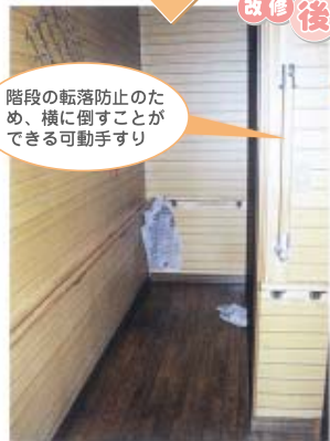
廊下に手すり設置。
