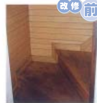
廊下及び階段上り口。
