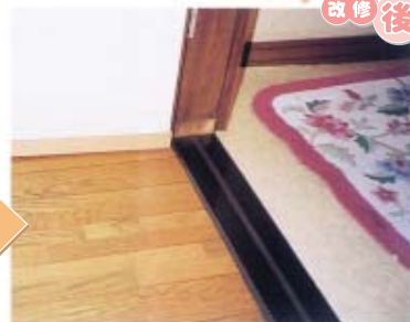
敷居を撤去して段差をなくし、ドア下端に生じたすき間を延ばす。
