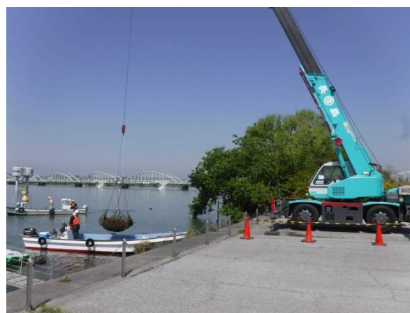
漂着物の陸揚げ作業 (H30. 4. 28)
