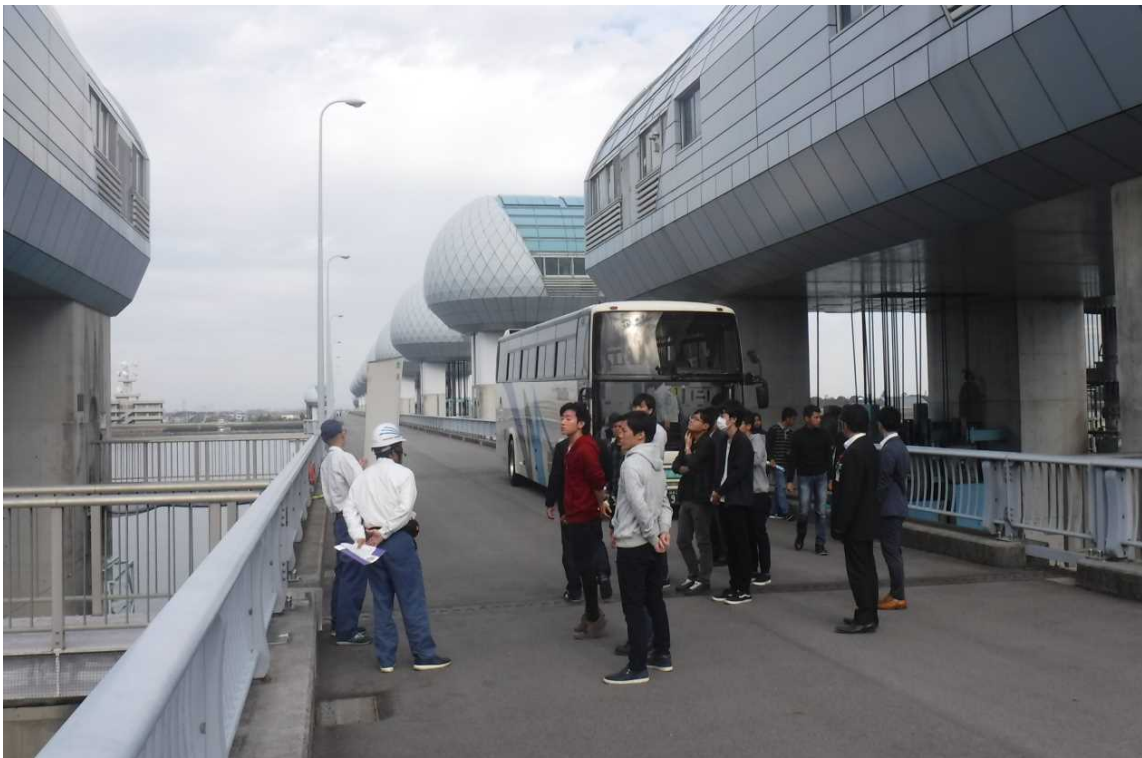
(H30. 10. 23 長良川河口堰県民調査団の視察状況)
