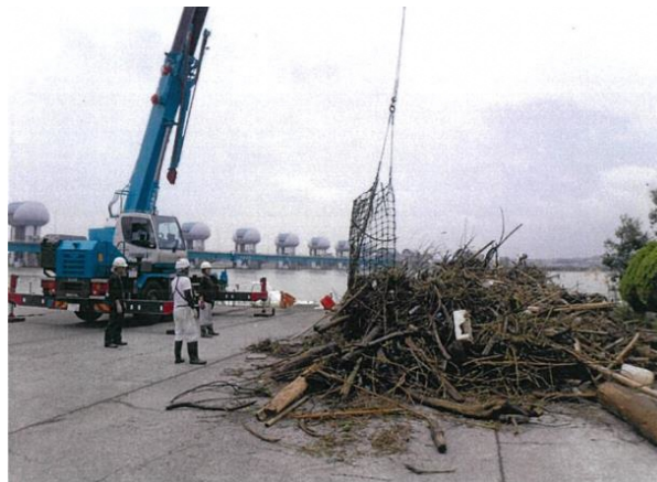
漂着物の陸揚げ作業 (令和元年7月2日)
