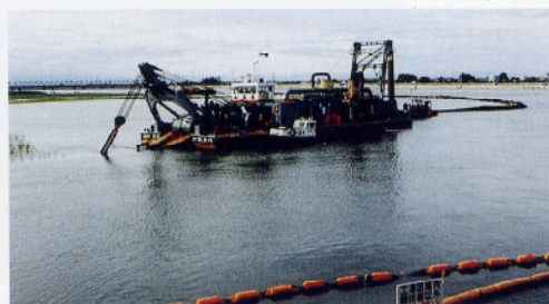
ポンプ船によるしゅんせつ
