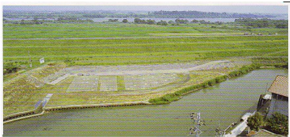
桑原川浄化施設(川裏)：最大浄化水量 / 毎秒0.3m 3
