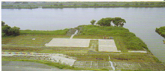
桑原川浄化施設(川表)：最大浄化水量 / 毎秒0.4m 3
