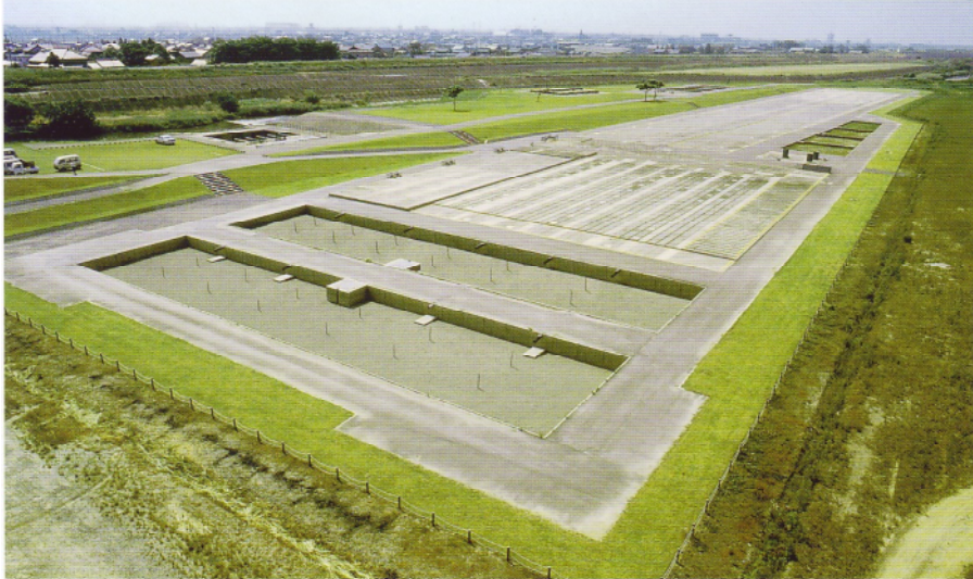
境川浄化施設：最大浄化水量 / 毎秒6.4m 3
