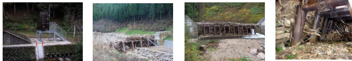
水位観測所 (城下橋上流・太江川) 【H16豪雨災害での流木捕捉状況】 飛騨市殿川災害関連緊急砂防事業(H12竣工) 飛騨市 宮川町森安 森安谷地内 (災害関連緊急治山事業(H11施工))
