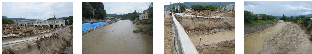
(福岡県朝倉市・大分県日田市の被害状況その②)
