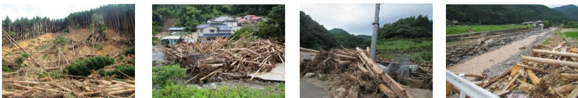
(福岡県朝倉市・大分県日田市の被害状況その①)
