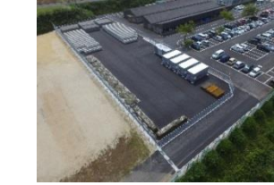
(災害時応急対策用資機材備蓄拠点(恵那拠点))
