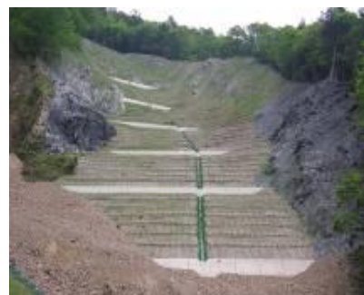
山腹の崩壊を防止する山腹工
