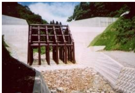
土石や流木の流出防止のための砂防えん堤
