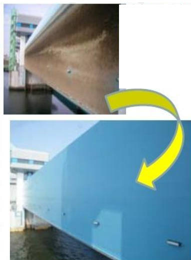
老朽化対策の例 (ゲート施設の塗装)
