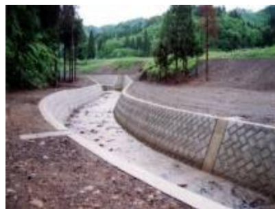
土石流の流れを制御する流路工
