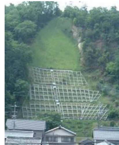
がけの崩壊を防止するのり面工
