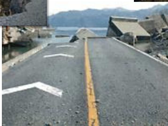
国道45号 岩手県釜石市
