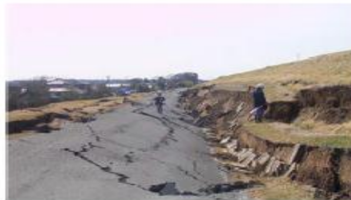
利根川下流 (右) 71k 付近 (千葉県印旛郡栄町) ※堤体も液状化している可能性
