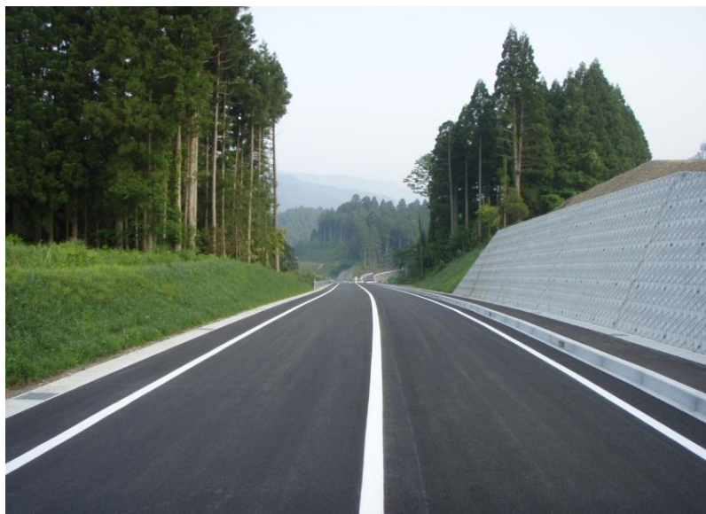
2車線改良されていけば通行できる可能性も高まる (写真は国道157号門脇バイパス)
