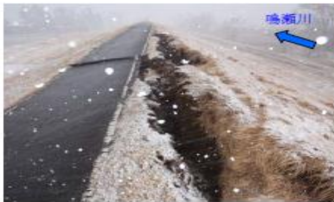
鳴瀬川 (左) 20k 付近 (宮城県遠田郡美里町和多田沼)
