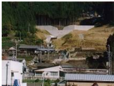
土石の流出防止のための砂防えん堤防
