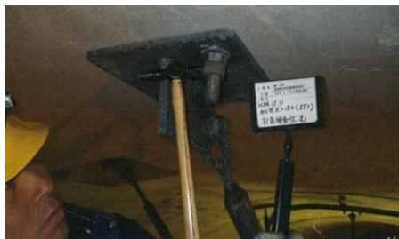
トンネル緊急点検等の実務に従事
