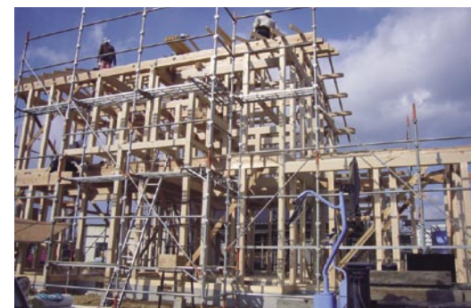
建築中の木の住宅
