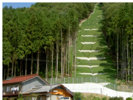
災害関連復旧治山事業
