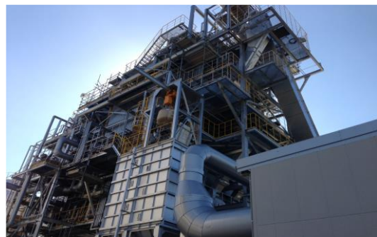
木質バイオマス発電施設（瑞穂市）
