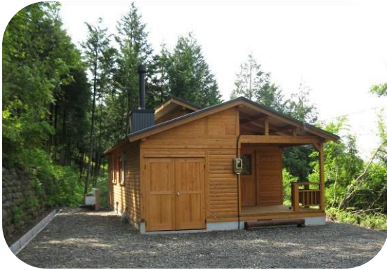
<古城山 管理棟（美濃市）>
