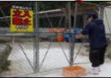
フェンス設置
