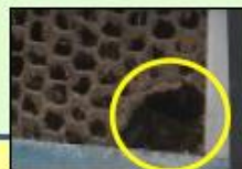
金網等の破損修繕
