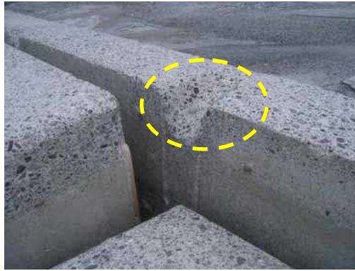
護床ブロックに生じた摩耗
